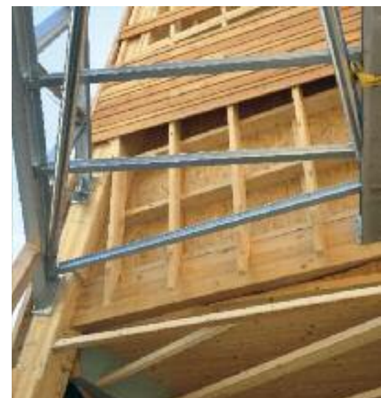
Abb. 5: Komplexe Turmaussteifung
