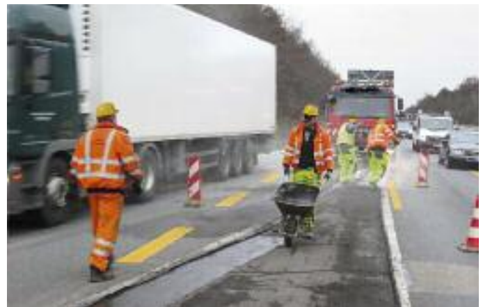
Abb. 2: Straßenbaustelle im fließenden Verkehr (Quelle: BG BAU)
