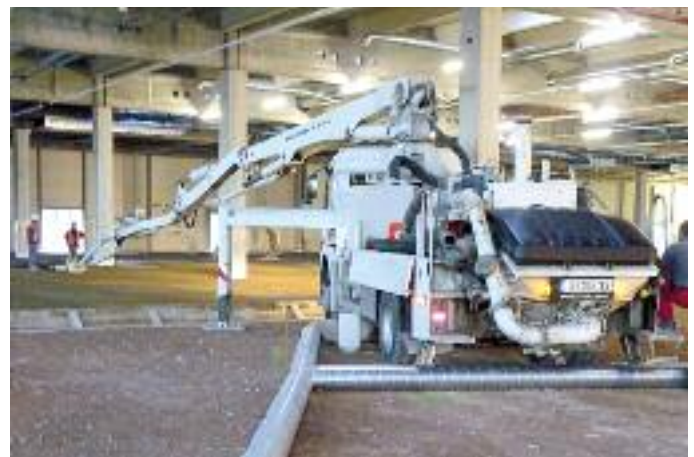
Abb. 4: Betonpumpe in einer Halle mit Absaugung am Auspuff
