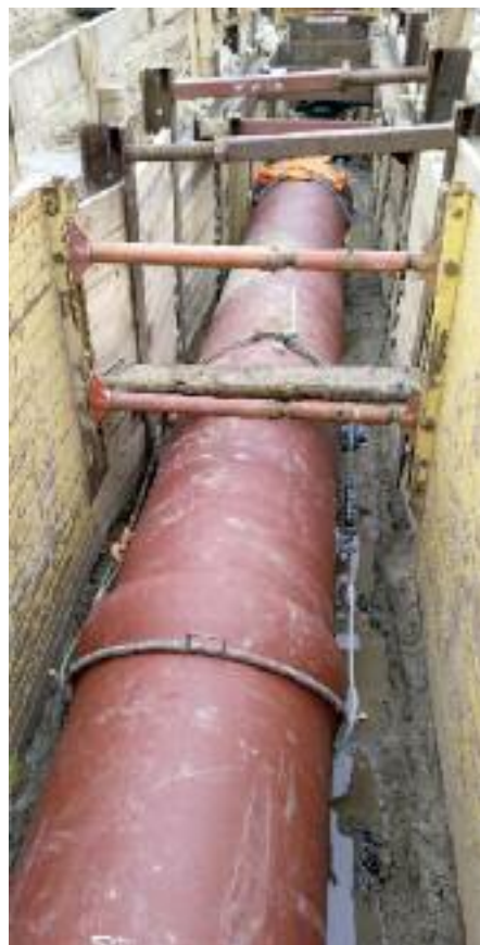
Abb. 1: Rohrleitung mit Kettenzug zusammengezogen
