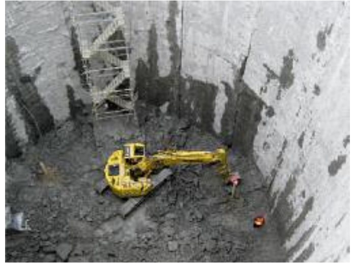
Abb. 6: Einsatz einer dieselbetriebenen Baumaschine in einem großen Schacht
