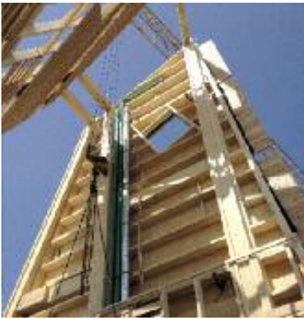
Abb. 6: Haustechnische Leitungen befinden sich in der Wandkonstruktion
