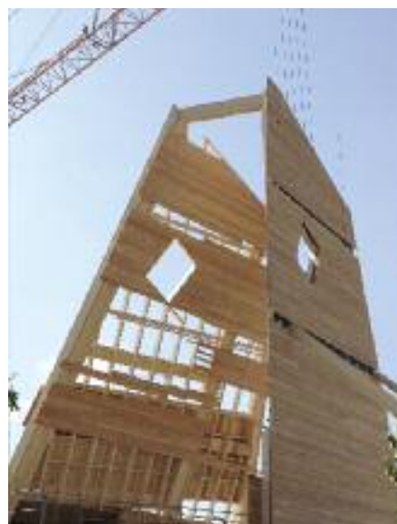
Abb. 4: Aufbau der Holzelemente mit Hubsteigern
